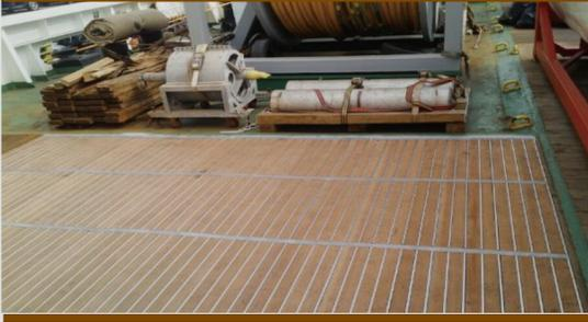
솔코파이로일렉의 자율제어형 히팅케이블은 통로 및 심한 경사 구간 등 노출된 표면의 용설(눈녹임)과 제빙(얼음제거)에 널리 사용되고 있습니다. 용설(눈녹임)은 보통 단위 제곱미터당 300watt 가량의 높은 출력을 요구하며 연평균 50시간 운영됩니다. 제빙(얼음제거)은 150watt/m<sup>2</sup>이하의 낮은 출력이 상시적으로 (년 평균2000시간) 가동되어야 합니다. 고유의 시스템 운영 기술과 자율제어형 히팅케이블을 사용할 경우, 기존 다른 방식과 비교하여 최고 80%까지 유지 비용을 절감할 수 있습니다.
