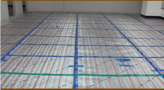
온수난방시스템에 비하여 설치와 관리가 용이하며 선박이나 플랜트 등의 복잡한 구조에서도 적용이 유리합니다. 이러한 솔코파이로일렉의 자율제어형 히팅케이블 (self-regulating heating cable)과 이를 활용한 히팅시스템은 가장 간편하고, 효율적이며 안전한 솔루션을 제공합니다.
